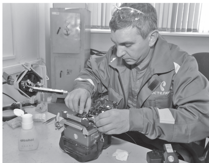
Чтобы отремонтировать повреждённый кабель нужны считанные минуты
